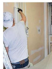
Lavori al policlinico
