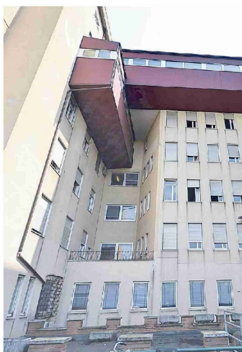
La palazzina di Ortopedia del S. Matteo, dove inizieranno i lavori
